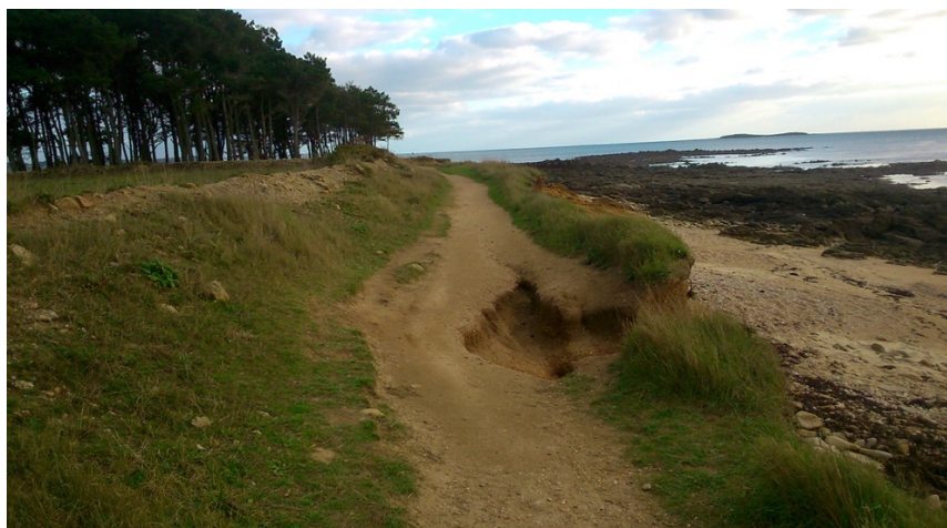
Portion du sentier côtier érodé au niveau de la Pointe Er Hourel
