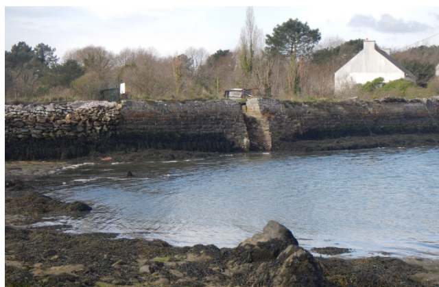
Digue de Toul Inis
